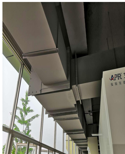
实验室废气收集后引入排气筒
