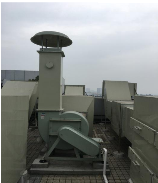
实验室废气收集后引入排气筒
