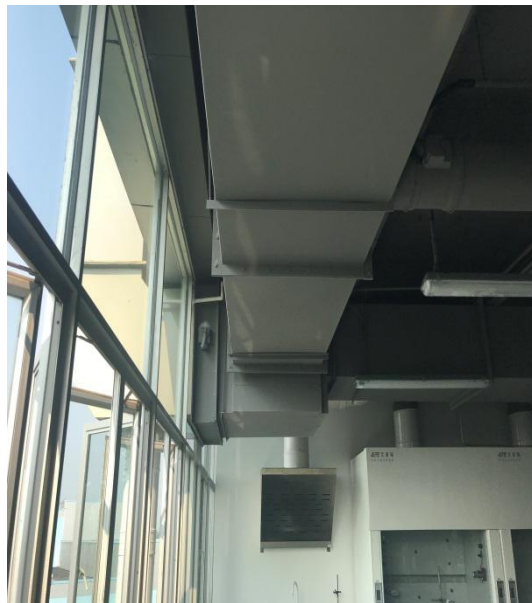
实验室废气收集后引入排气筒
