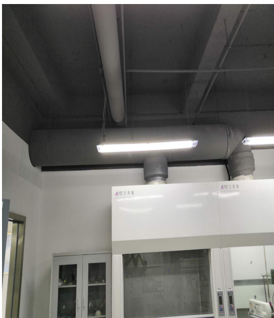
实验室废气收集后引入排气筒
