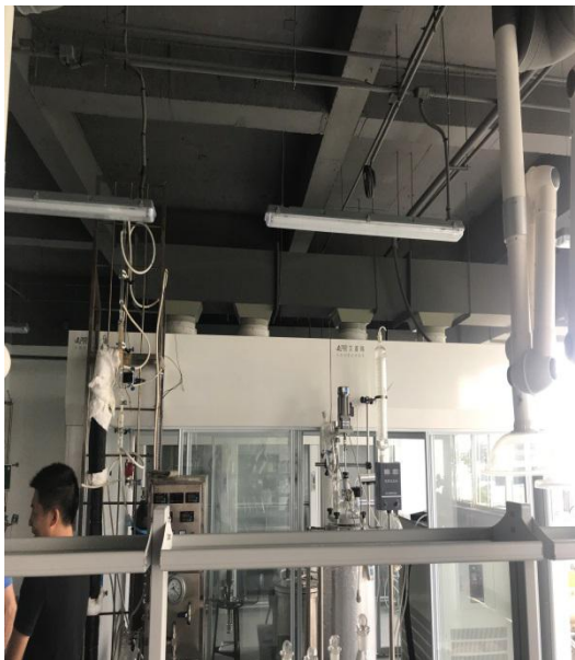
实验室废气收集后引入排气筒
