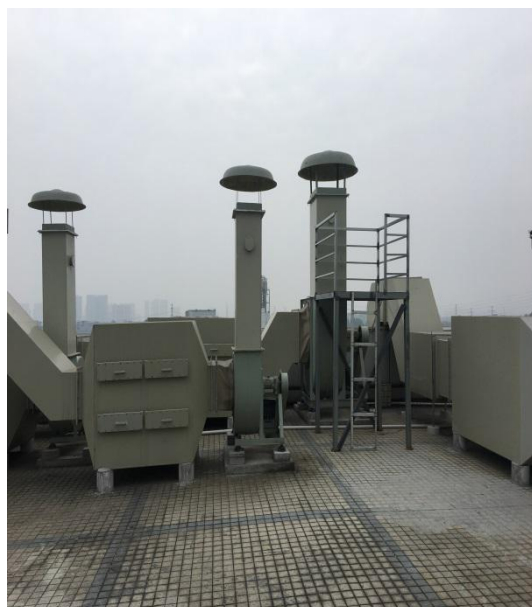
实验室废气收集后引入排气筒
